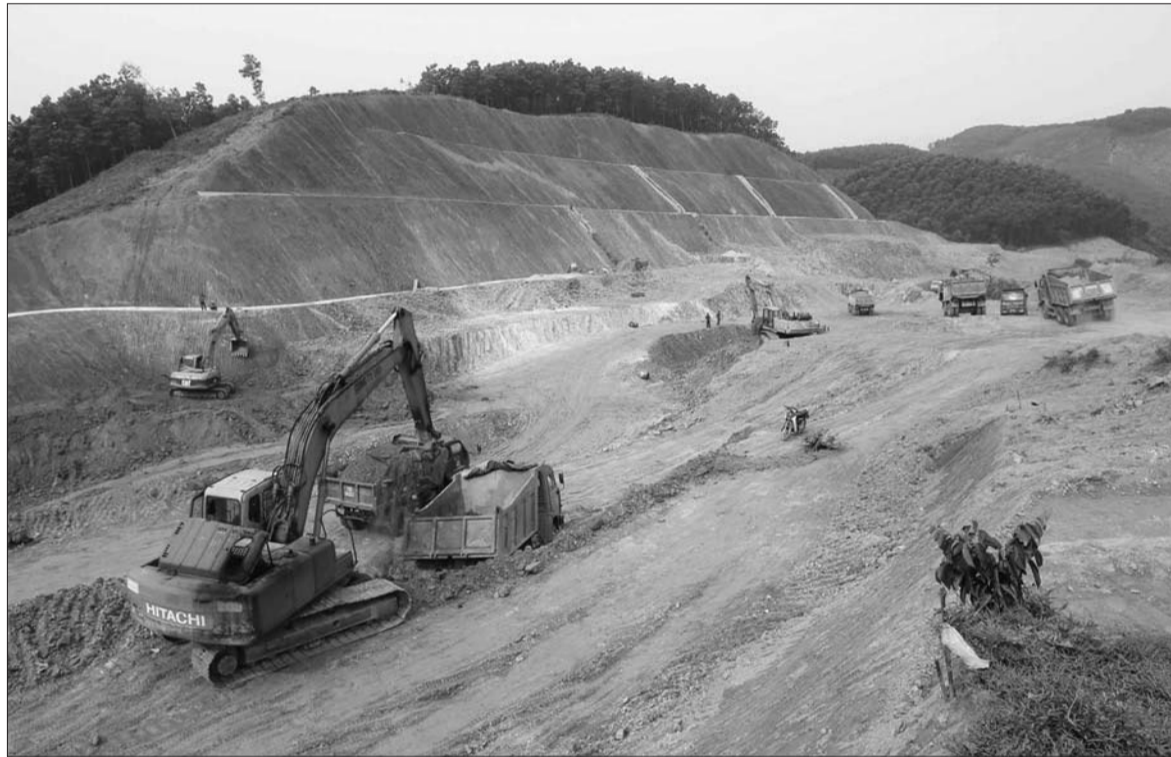
Thi công trên tuyến đường La Sơn - Túy Loan
